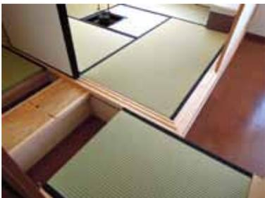
④水屋の入口は、茶室に合わせて廊下に張り出しているため、普段は畳をスライドさせて引き込めるように工夫しました。
