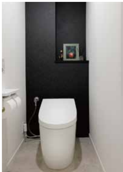
⑧タンクレストイレの TOTO ネオレストでリフォーム。モノトーンのすっきりとしたトイレ空間になりました。
