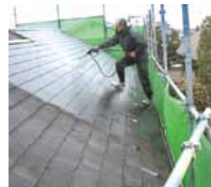
近隣に配慮して高圧洗浄
