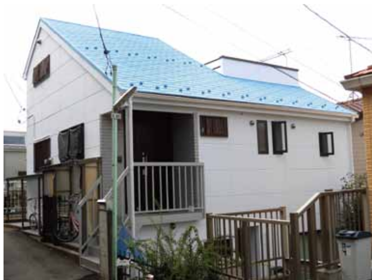
T様邸は3階建ての2世帯住宅。2、3階の子世帯住宅には2階から入れます。さわやかなライトブルーの屋根と白い壁に生まれ変わり、通りゆく人の目をひきます。
