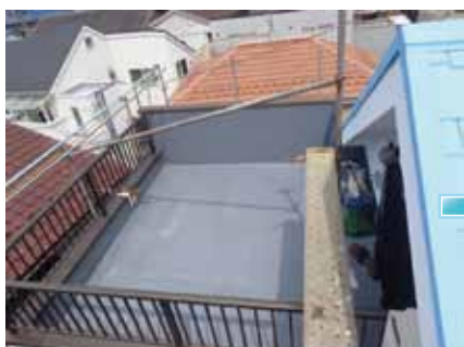
工事中。ベランダは以前は夏は暑すぎてとても裸足では歩けませんでした。
