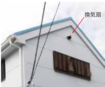
3階の壁面に新しく換気扇を設置。これにより空気が循環できるようになりました。
